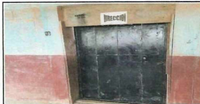
Foto 6: Cambio de puerta de Dirección.
